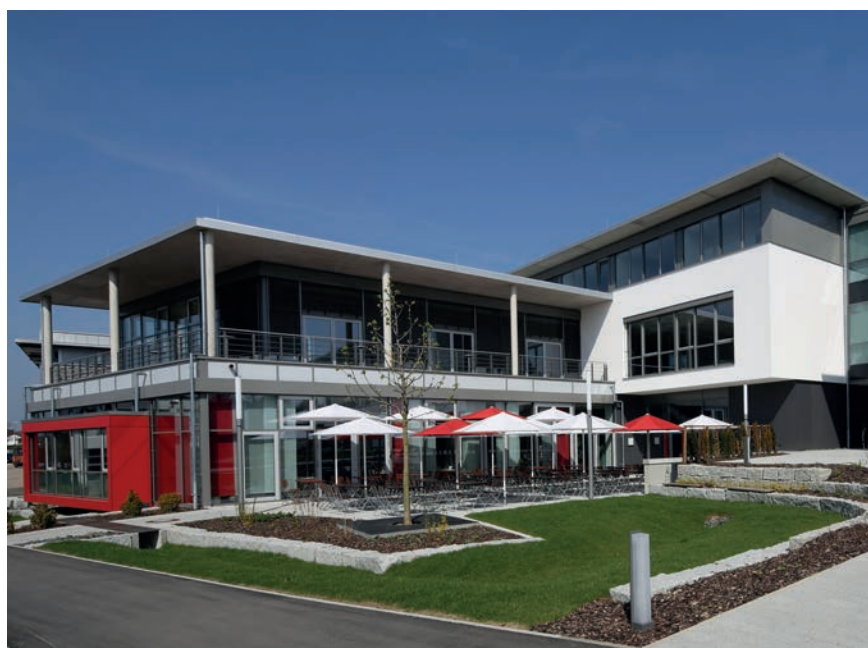
Bild 1: Innovationszentrum am ZwickRoell Stammhaus in Ulm
